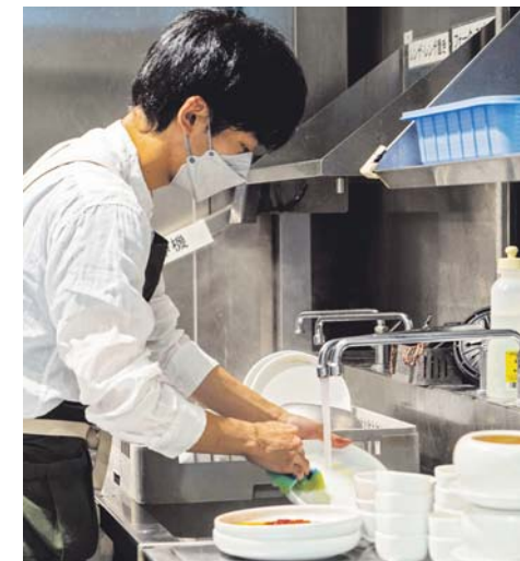
Spülwasser: Das mit dem Methan erhitze Wasser ist für die Nutzer kostenlos. Pro Tag 630 kWh Wärme erzeugt der Boiler, also rund 220 000 kWh im Jahr. Foto: Martin Egbert
